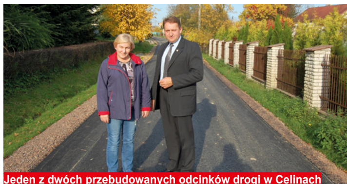
Jeden z dwóch przebudowanych odcinków drogi w Celinach
